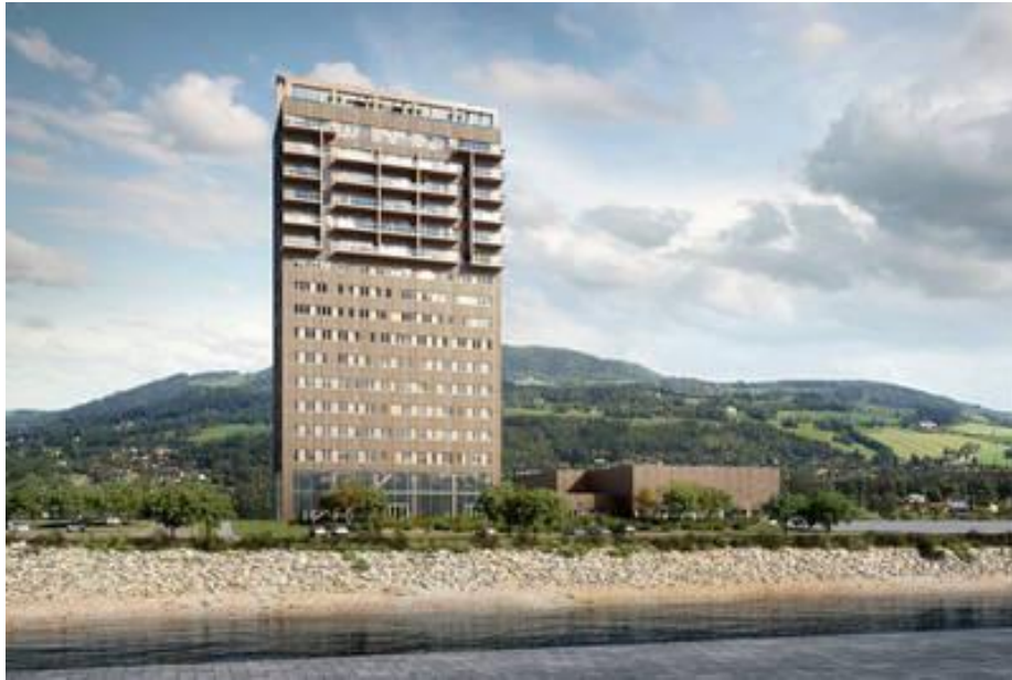
Figure 2: Mjøstårnet in Brumunddal (Norway)
